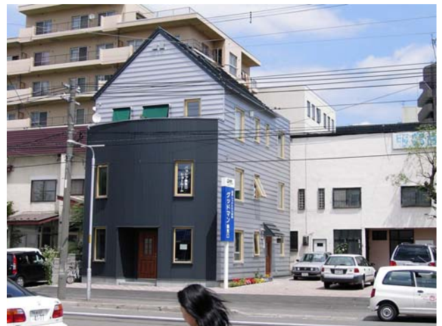
図2 測定住宅の外観
