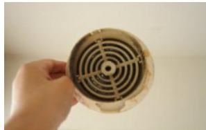
目詰まりを起こし、換気能力を失った換気口
