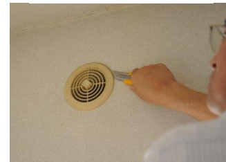
古い換気口を取り外す
