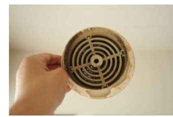
古い換気口の内部(埃が付着し、完全に目詰まり状態)
