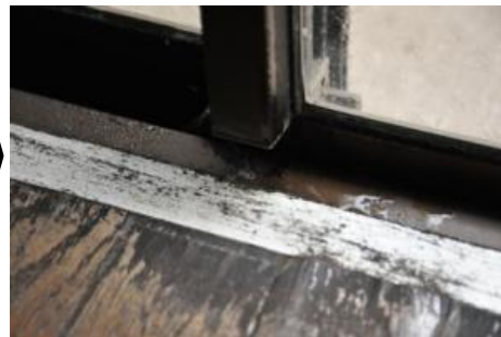
結露による腐朽菌に侵された サッシの額縁とフローリング
