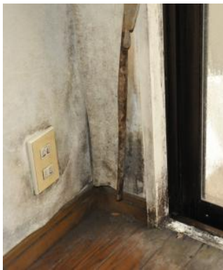
結露によって発生した 壁紙の剥離とカビ 結露はコンセントの中にも
