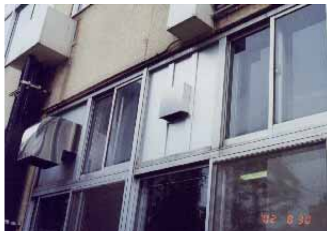
図1 換気口の外側写真
