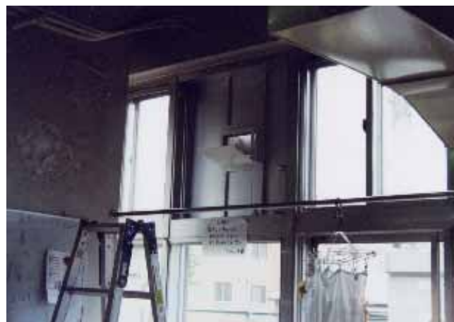
図2 配膳室内の換気口
