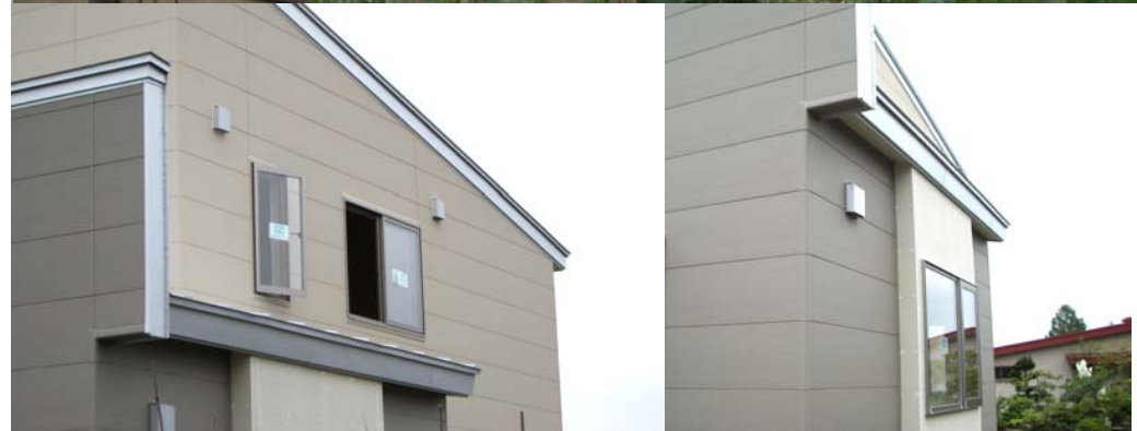
青森県十和田市 新築工事
