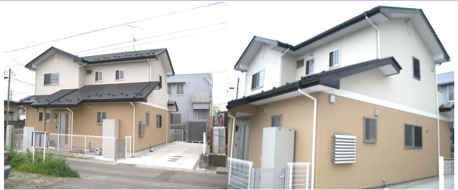
福島県福島市 新築工事
