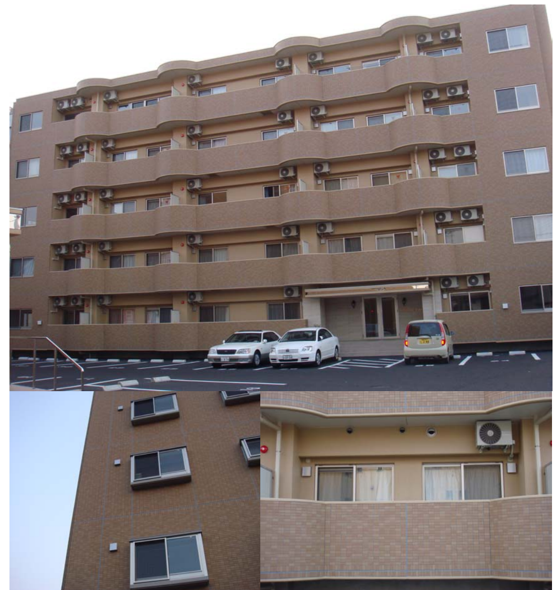
山形県山形市 新築工事
