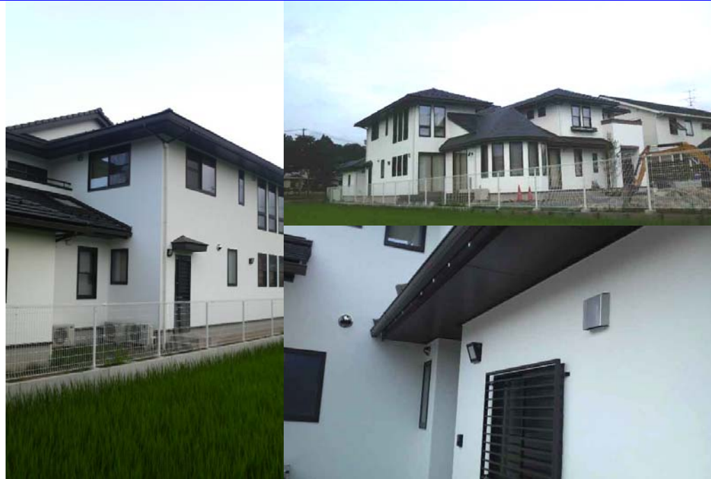
宮城県白石市 新築工事
